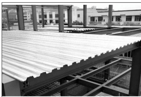
Tablier métallique et toiture métallique.
